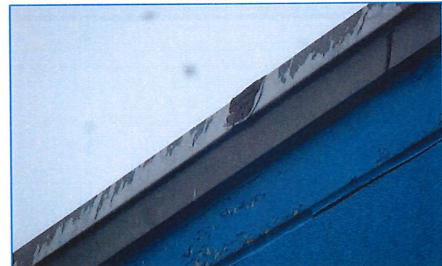
Foto 6: Dachbleche mit möglichen Spaltenstrukturen für Fledermäuse
