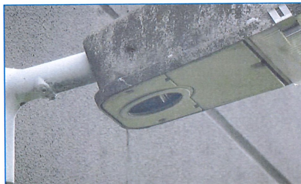
Foto 5: Feldsperlingsnest in Lampenfassung am Gebäude
